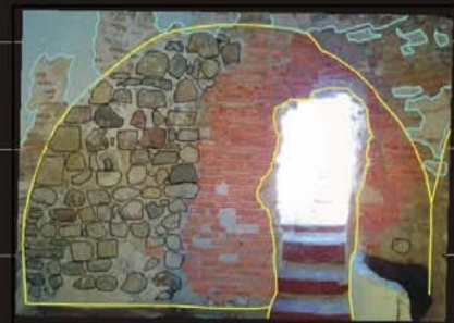
PARAMENTO 2ª PLANTA
